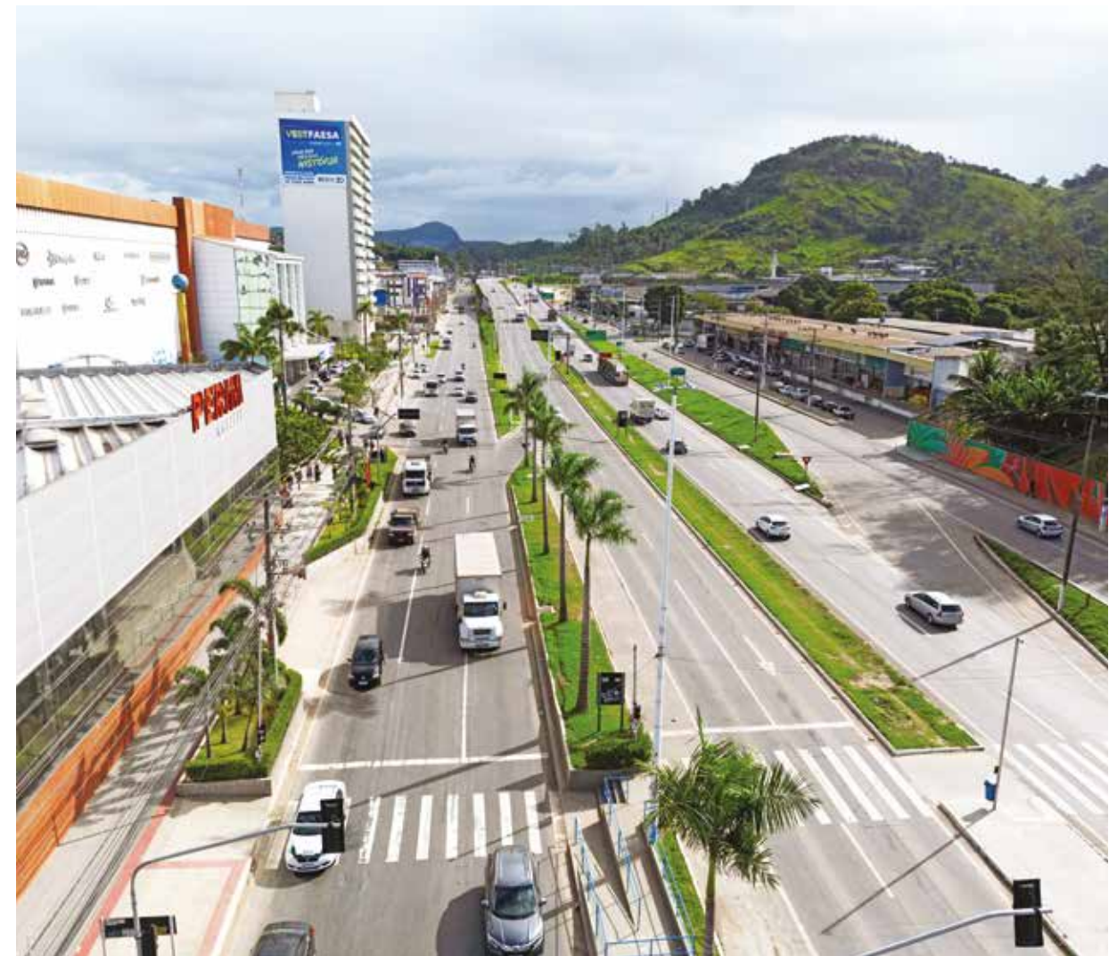
Municipalização e revitalização da Av. Mário Gurgel, do viaduto do Contorno até a 2ª Ponte
